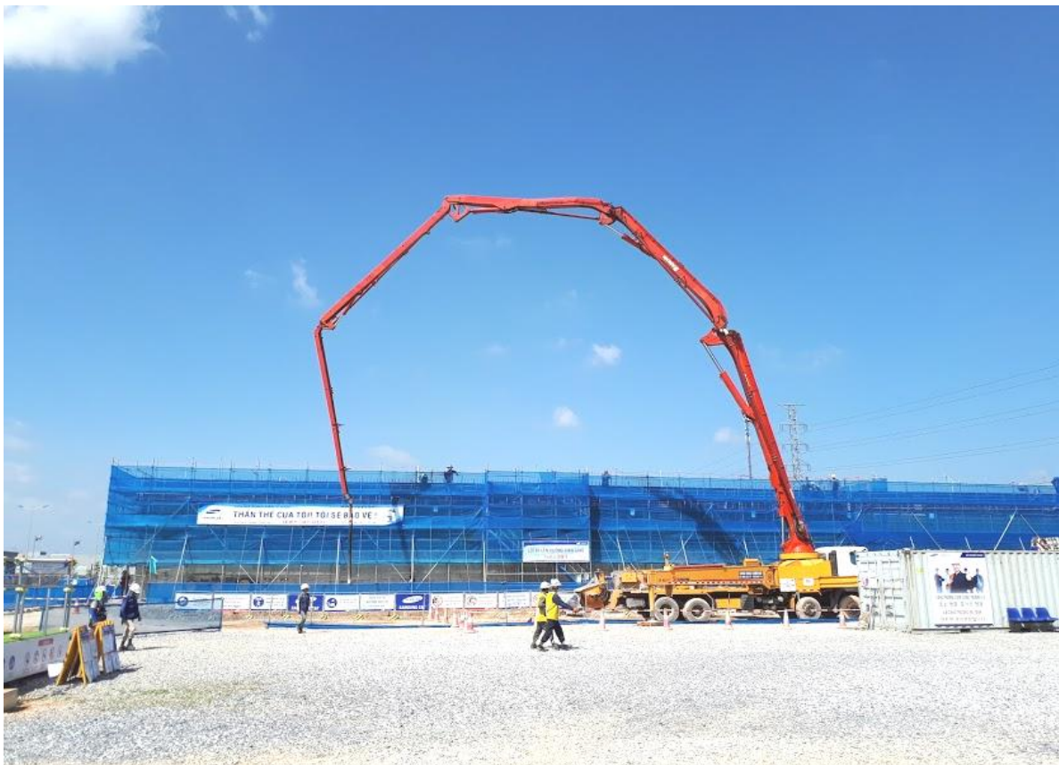
Dự án bể chứa nước sạch CW tank 50.000m 3 Samsung Thái Nguyên
