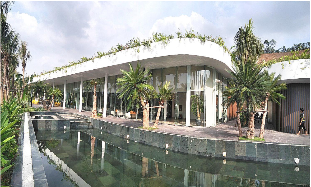
Thi công nhà điều hành Flamingo Đại Lải
