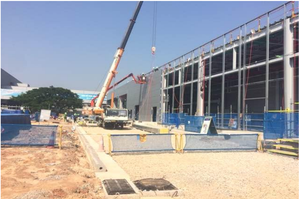
Thi công Nhà xưởng dự án Samsung Thái Nguyên
