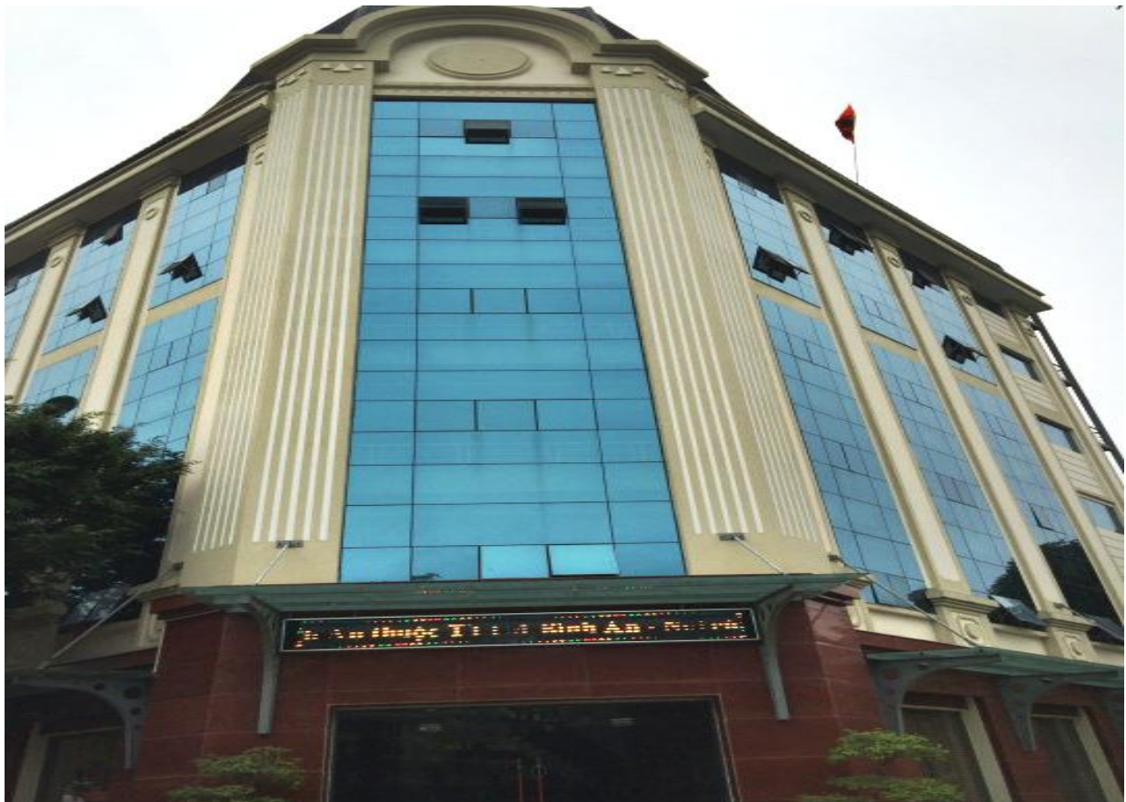
Thi công Khách sạn Bình An
