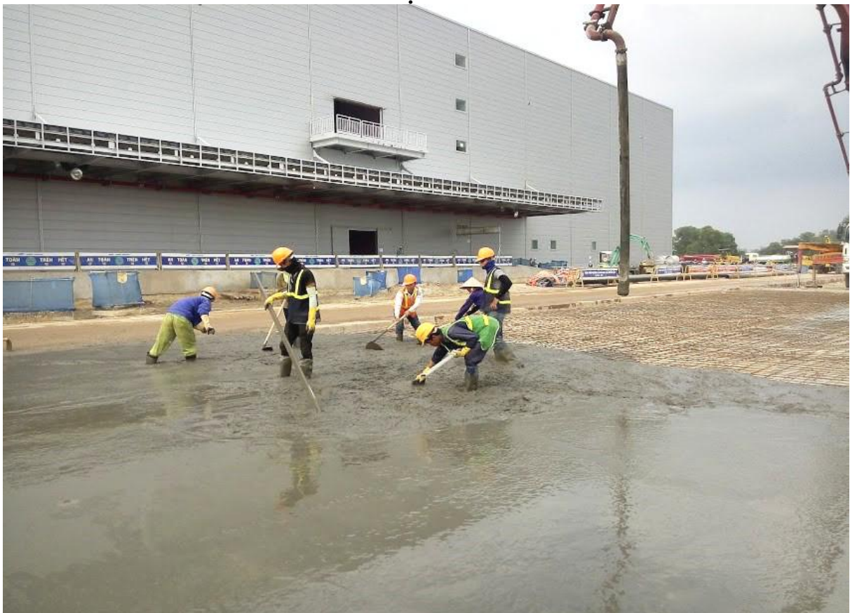
Thi công tuyến đường chính Samsung Thái Nguyên
