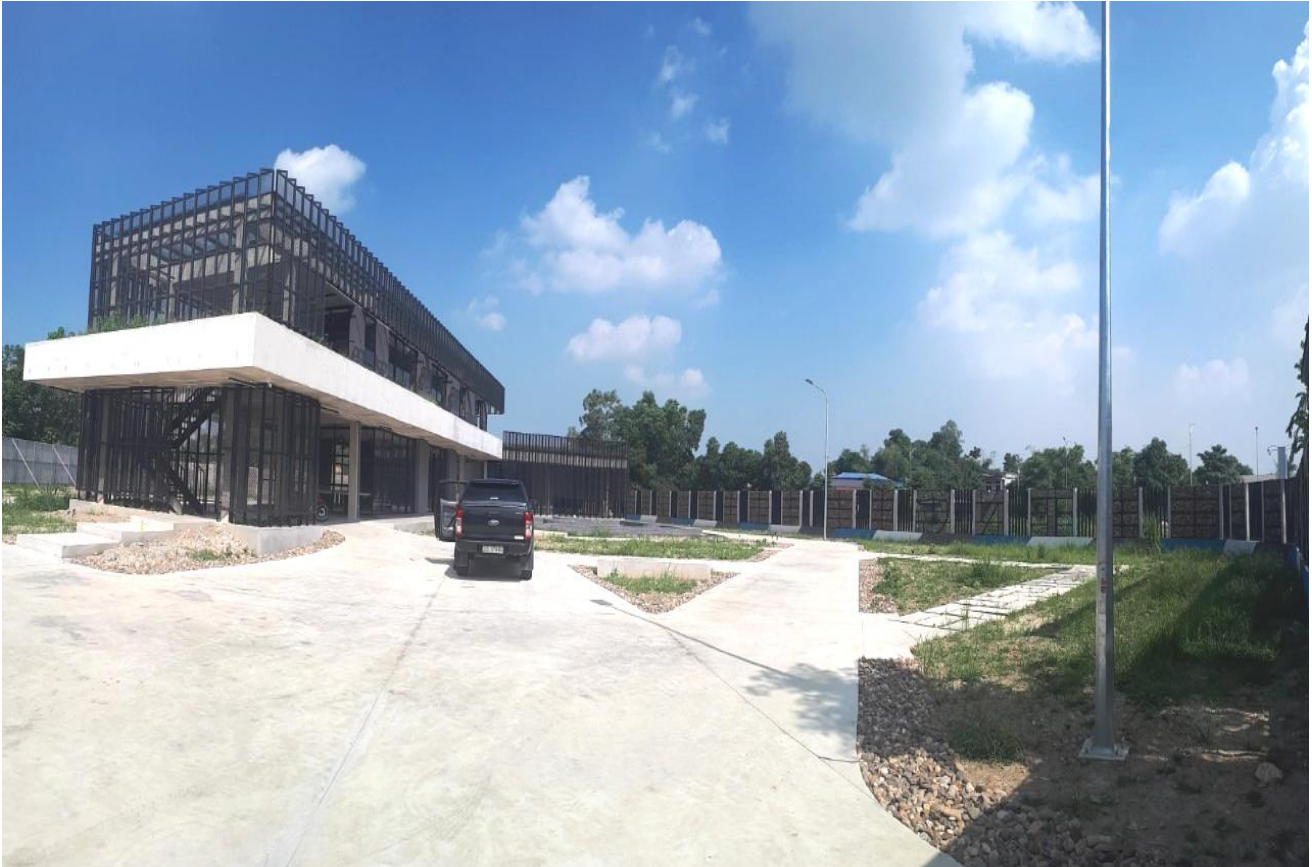
Thi công cụm công nghiệp Sơn Cẩm
