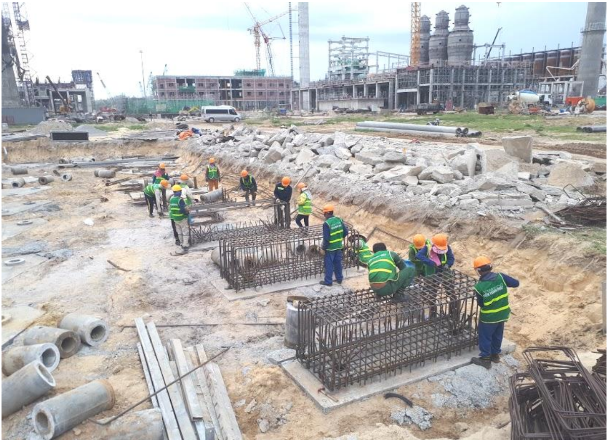
Thi công dự án nhà máy thép Hoà Phát Quảng Ngãi
