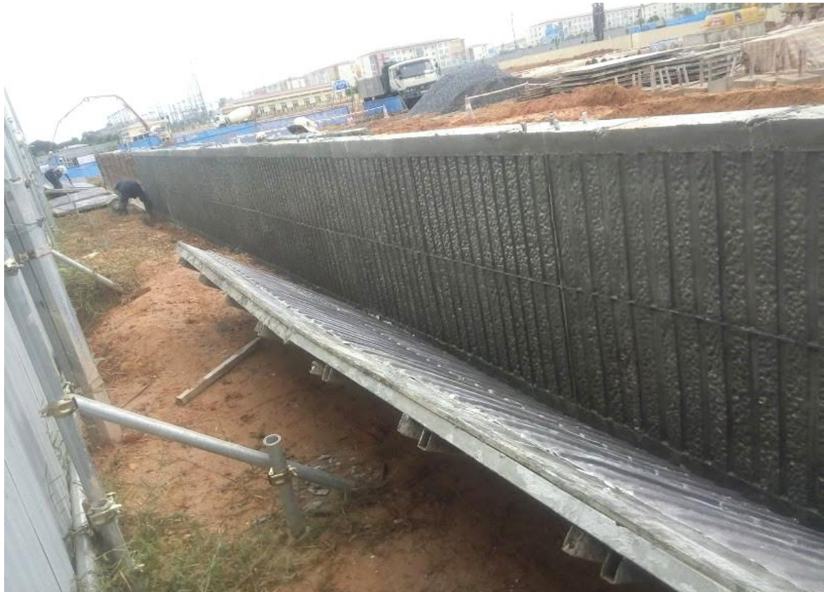
Thi công hệ thống tường chắn, hàng rào chính dự án Samsung Thái Nguyên
