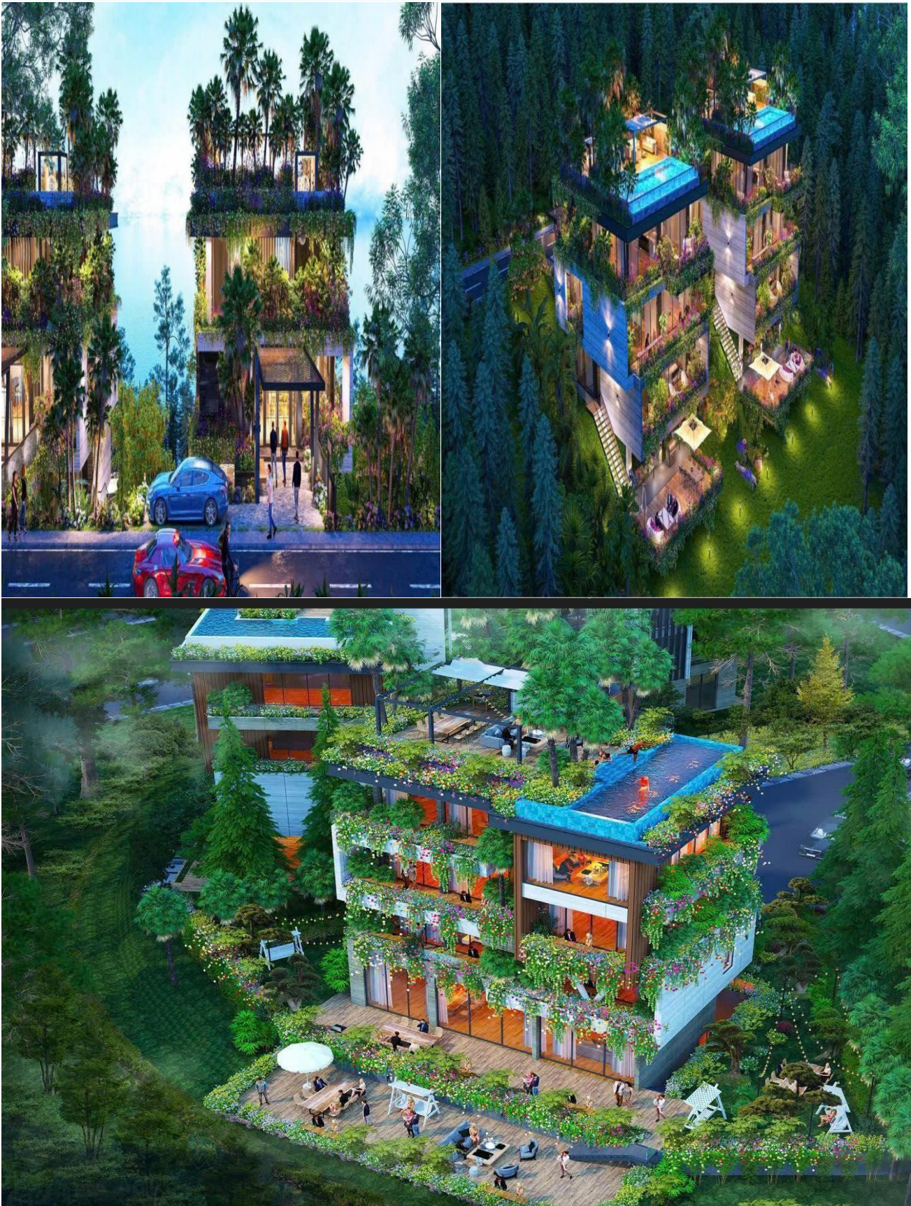
Thi công căn Biệt thự mẫu tại Flamingo Majestic Island Resort Thái Nguyên
