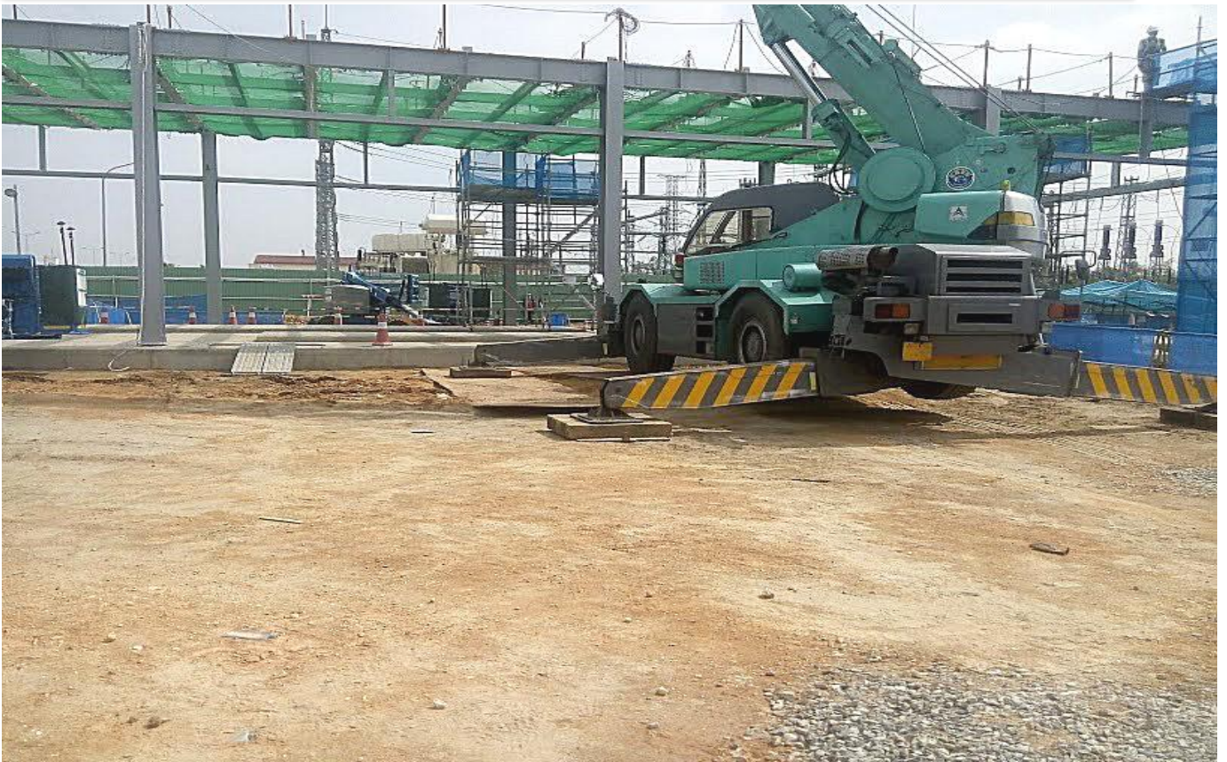
Thi công Nhà Điện dự án Sam Sung Thái Nguyên
