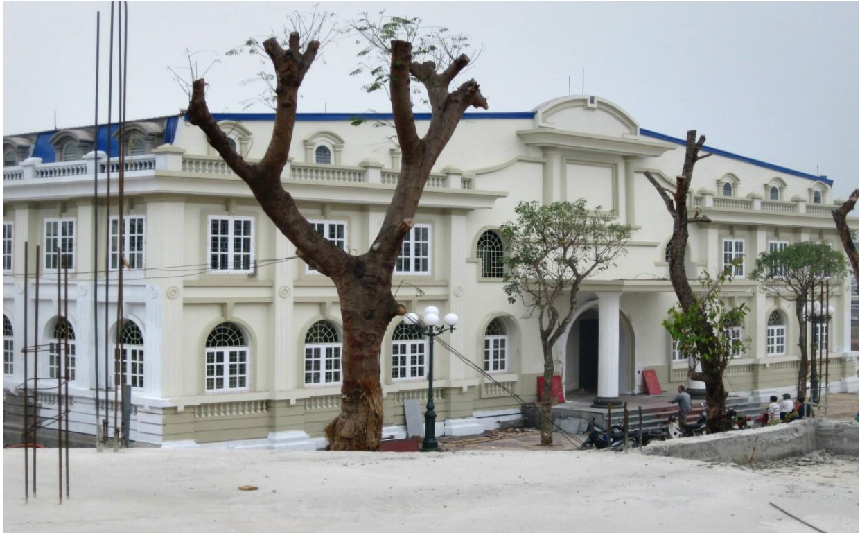
Thi công trung tâm thương mại Bình An
