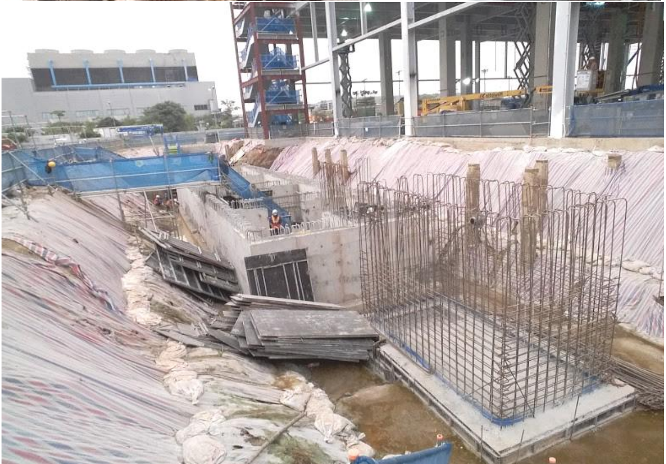
Thi công hệ thống bể ngầm dự án Sam Sung bắc Ninh
